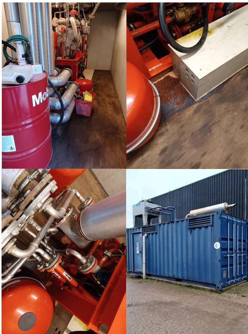
Figur 6: Oliespild omkring gasmotor
