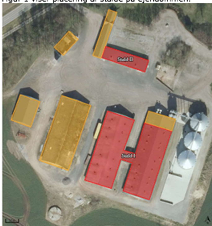
Figur 1 Placering af staldene på Ørsøvej 140
