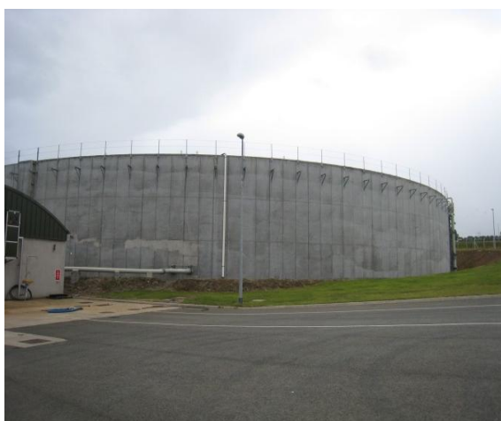
Foto 1: Dairygold's anlæg med reaktor og flydende overdækning.
