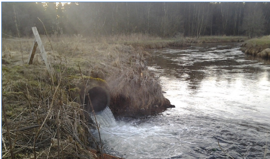
Figur 3 Udlledning af rensede spildevand fra Arla's fælles renselanlæg, februar 2013. Udledningspunktet er placeret i åbrinken. I baggrunden t.v. skimtes tilløbet af Egeris Mølleå, opstrøms udledningen.
