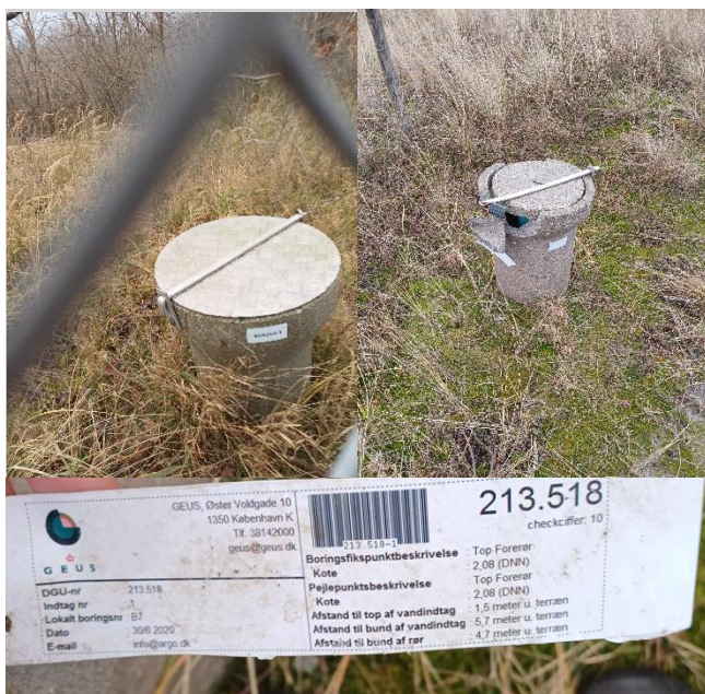
Boringer: Boring 7 defekt DGU 213.518
