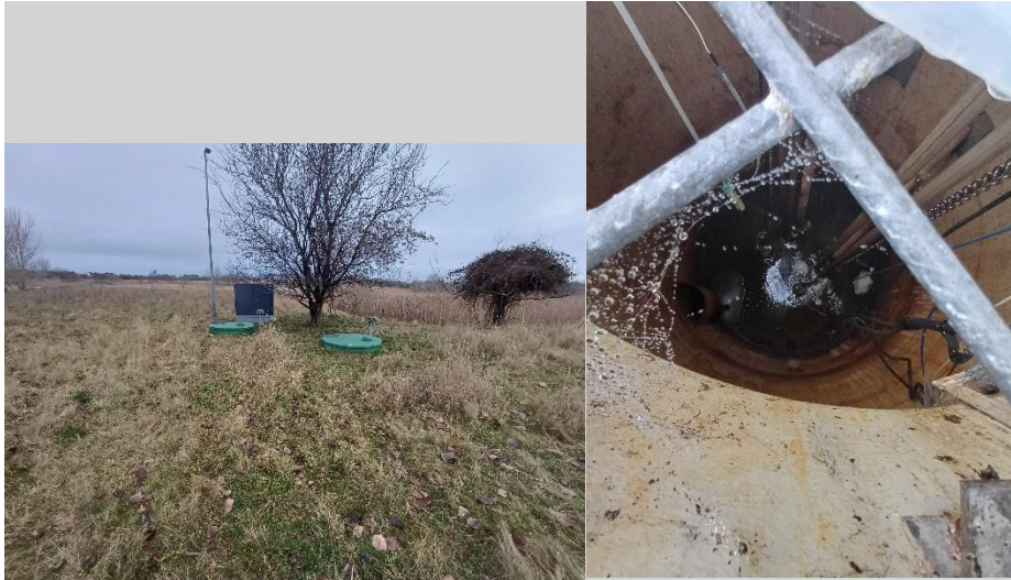
Perkolatbrønd og fordelerbrønd
