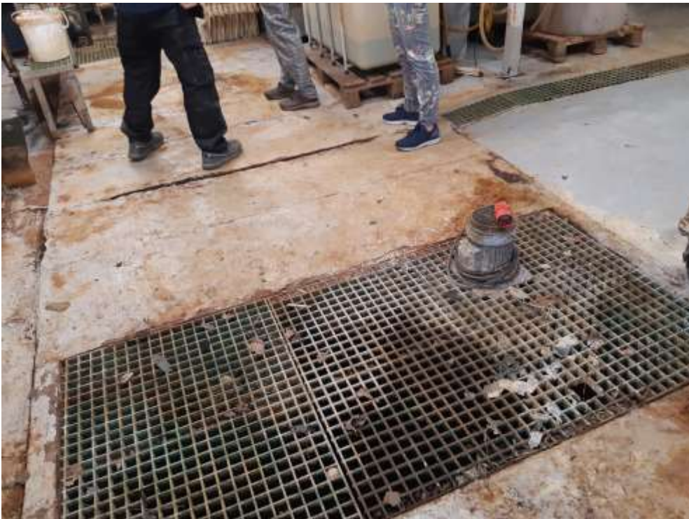
Spildevandstank, 45 m 3 , under gulv
