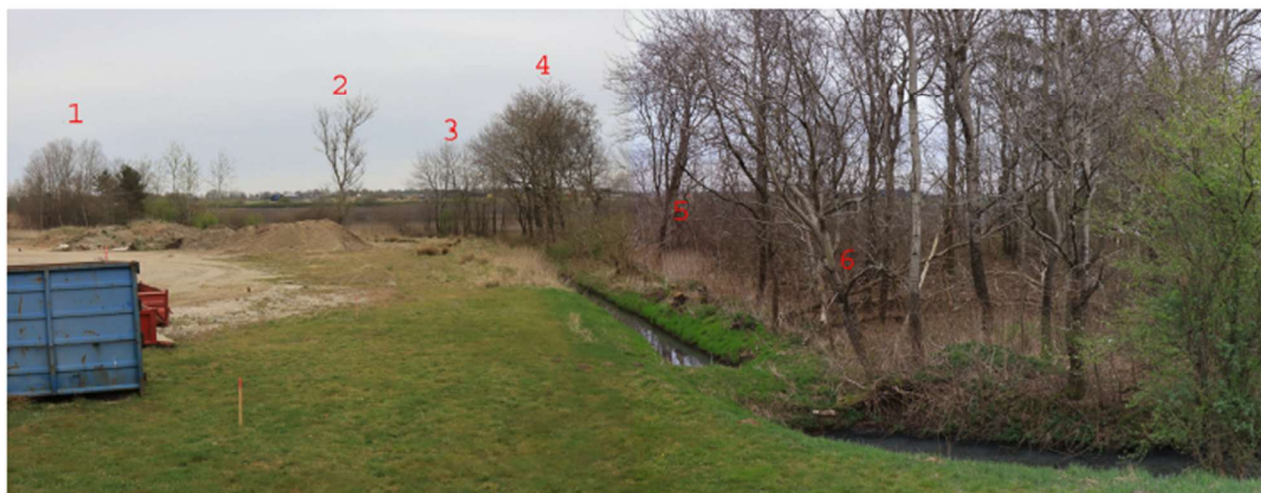
Figur 3. Nedsivningsgrøft, der ses langs med beplantningen. Grøften har ingen forbindelse til Fiskbæk.
