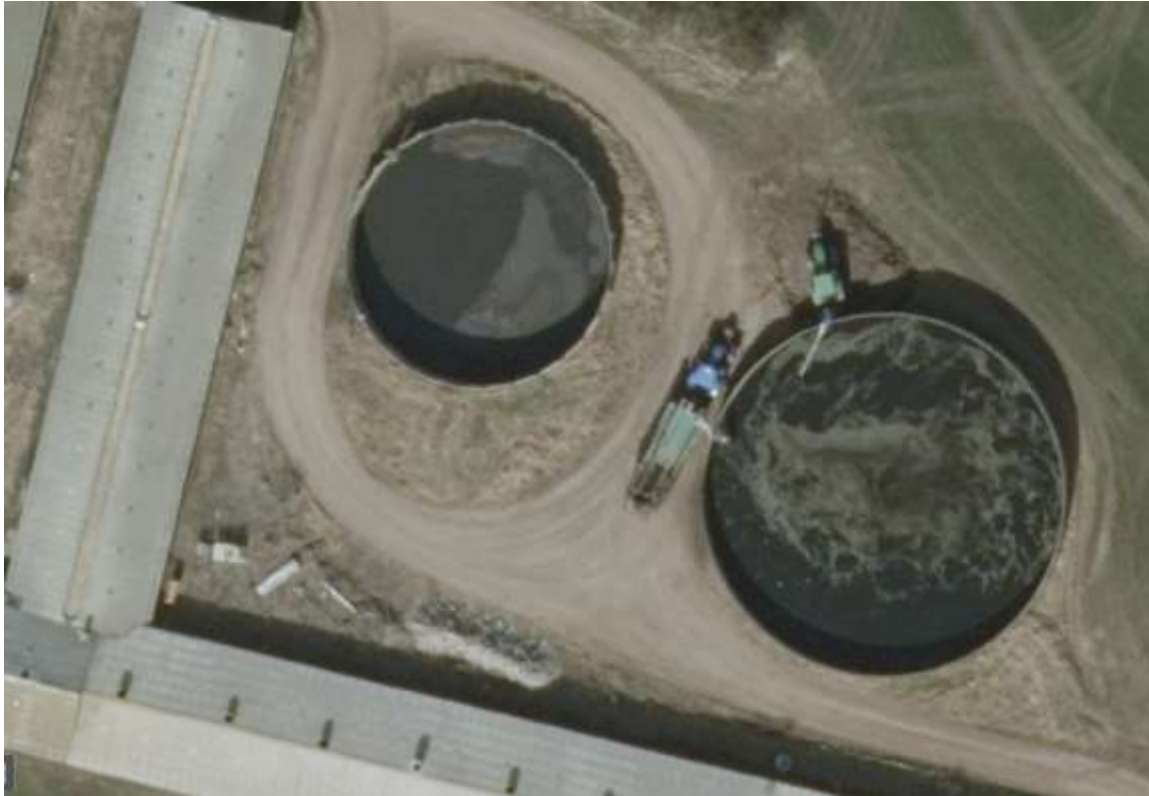
Ortofoto fra 2018 af gyllebeholdere på Mårupgårdvej 8. Begge beholdere vurderes at være i drift.
