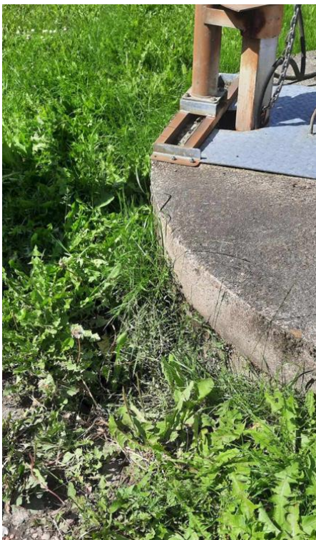
Figur 15. Afløb nær fortank.
