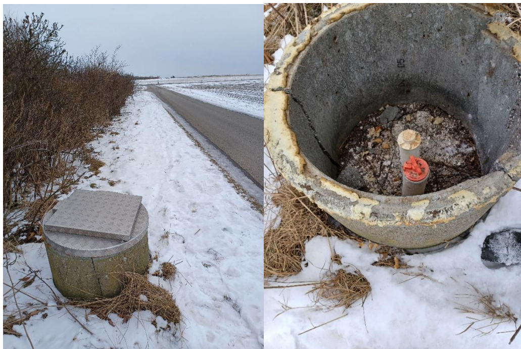
Fotosamling 1. Grundvandsboring ved Stokhøjvej mod syd.
