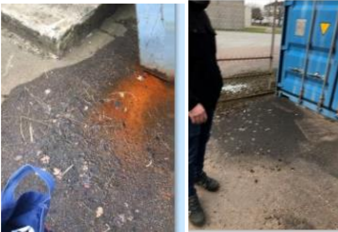
Foto 2a-b: Misfarvet belægning på udendørsarealer
