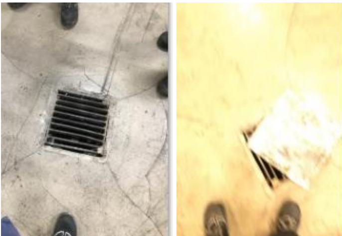
Foto 3a-b: Rist indenfor i lageret
