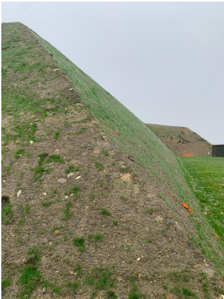
Figur 6 Støjvolden har en meget stejl skråning
