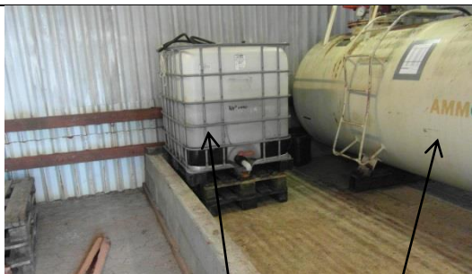
Billede nr. 2: Oplagsplads til tank med ren ammoniak og palletank med NH 3 -vand (2016)
